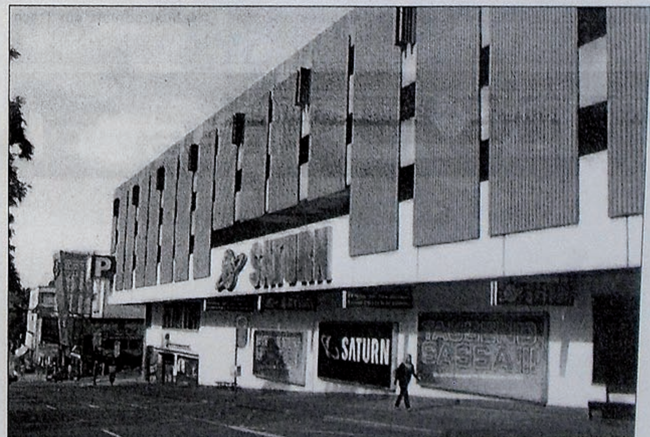
Erneuert werden soll die Fassadengestaltung des Parkhauses: Die braunen Trapezbleche werden durch farbige Glaslamellen ersetzt.
