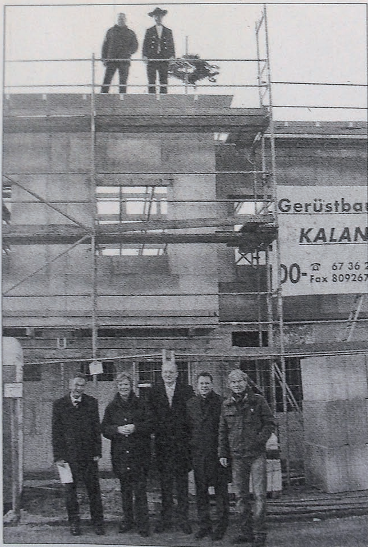
IGW-Geschäftsführer Holger Lohrbach (li.) mit seinem Team und Architekt Siegfried Brüggemann (re.) beim Richtfest. Foto: Merkel
