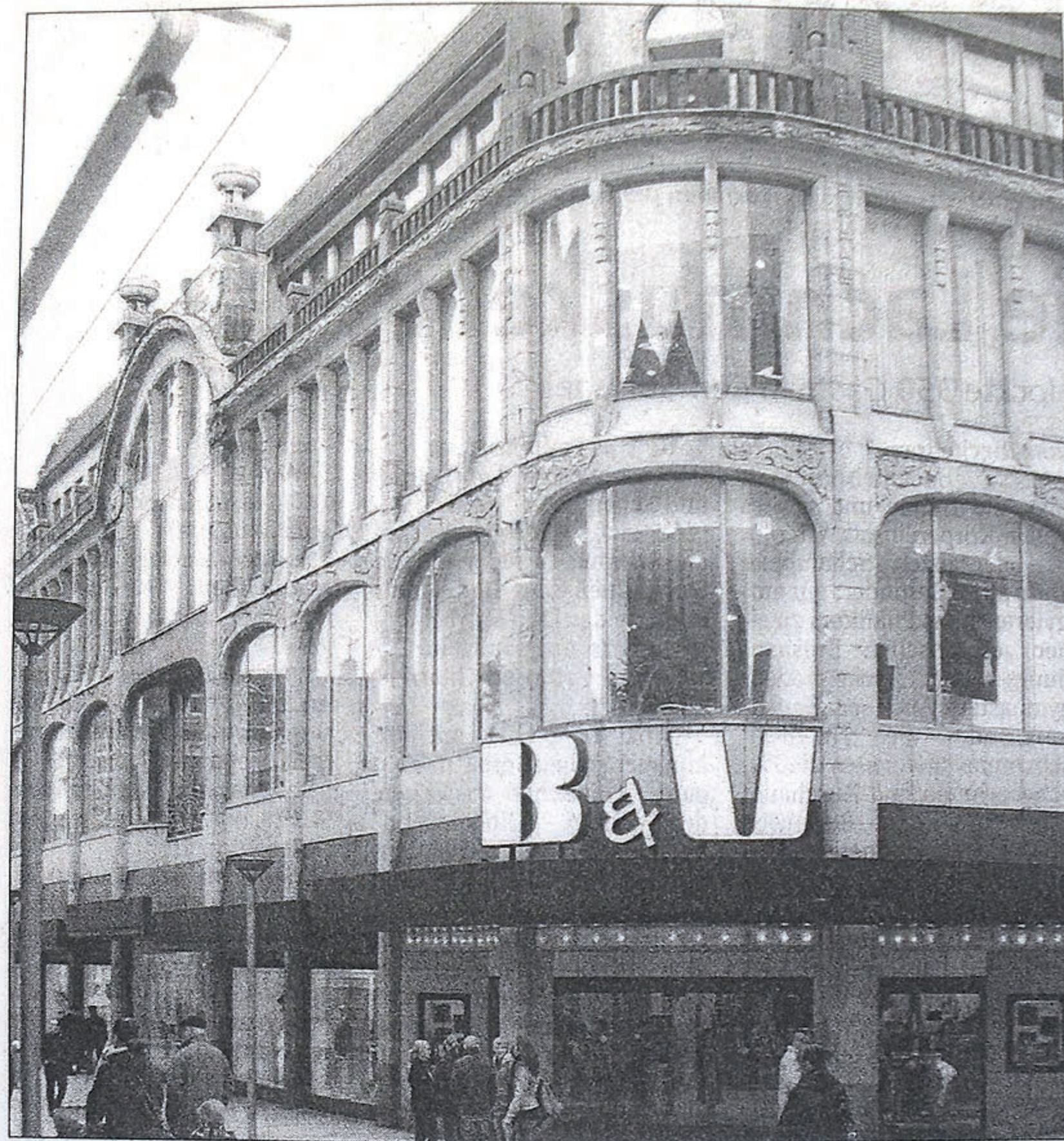
Zurück zu den baulichen Wurzeln: Die Eloxal-Elemente an der B&U-Fassade werden entfernt, um die ursprüngliche Gebäude-Gestaltung wieder sichtbar werden zu lassen. Foto: May
