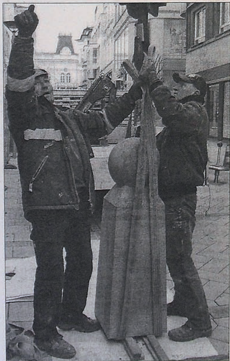
Unten auf der Unnaer Straße wurde der Kopf des Obeliskens vertaut und hochgezogen.
