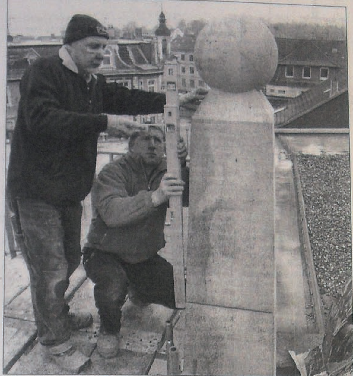
Oben, auf dem Dach des Kaufhauses, wurden die beiden Teile des Obeliskens zusammengesetzt.
